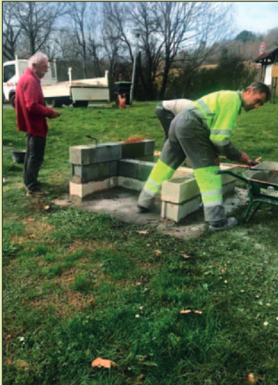
Construction d'un barbecue au Lézert
