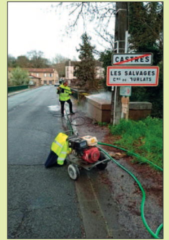
Peinture et nettoyage des rambardes du pont des Salvages
